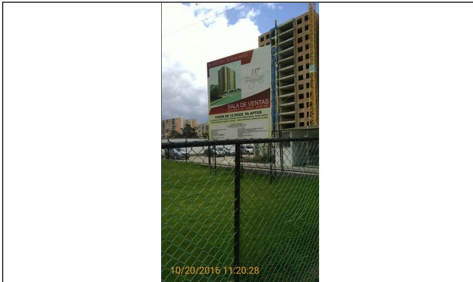
Fotografía 1: vista panorámica de la valla de obra convencional sentido oeste – este, cuenta con registro.
